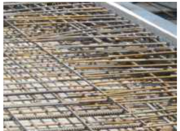
Deckenbewehrung, Randeinfassung
