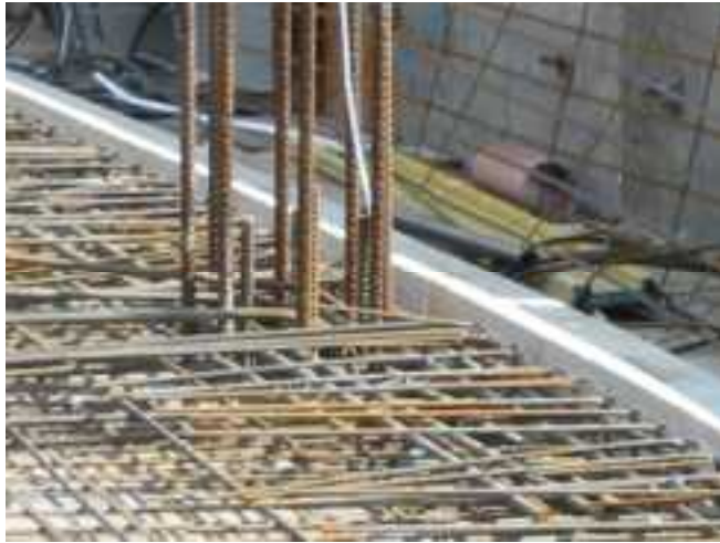
Deckenbewehrung, Anschluss Stütze
