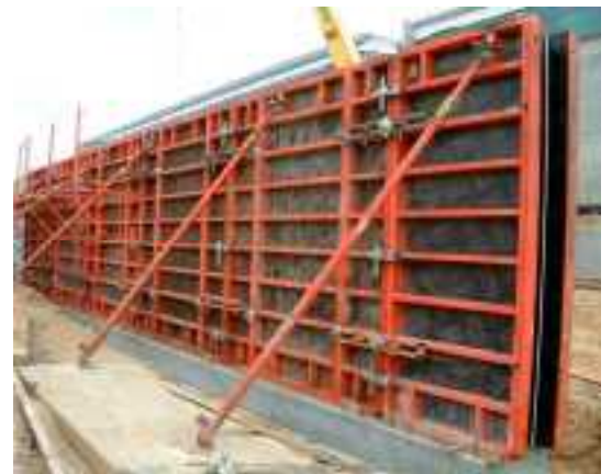
Schalung aus vorgefertigten und wieder verwendbaren Elementen
