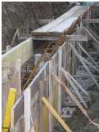
Vor Ort gefertigte Schalung aus Brettern
